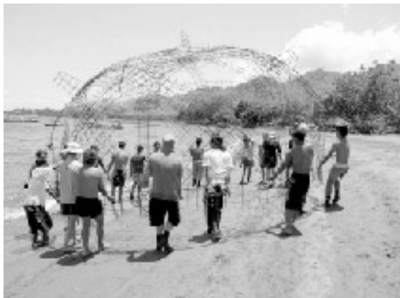
図2. 第3回Biorockワークショップ(2004年11月)で電着モジュールBiorockを海中に設置しようとしているところ (Global Coral Reef Alliance提供)
