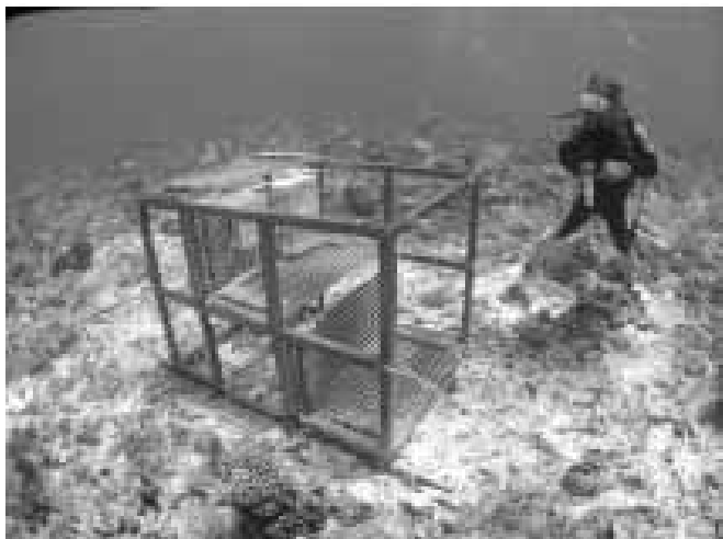
写真6. サンゴ増殖礁の設置（沖ノ鳥島）
